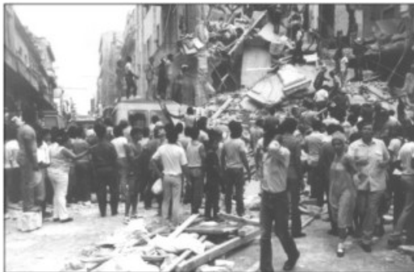
Muchos de los añejos inmuebles existentes en nuestra capital ya no resisten el embate del tiempo y la falta de mantenimiento. La foto de Silvio del Valle corresponde al derrumbe ocurrido hace años en un edificio de las calles Consulado y Trocadero, en Centro Habana.
